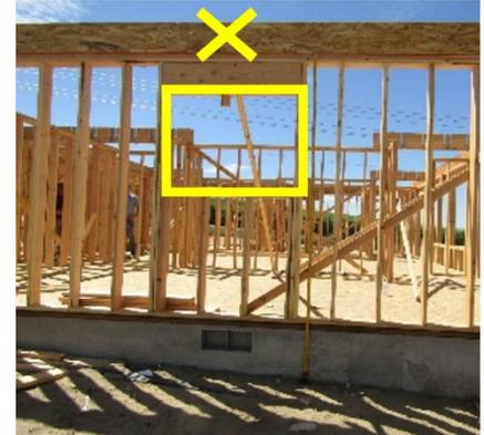
El instalador de estructuras cayó de la viga de borde (x) sobre la abertura de la ventana y hasta el entablado del piso.
